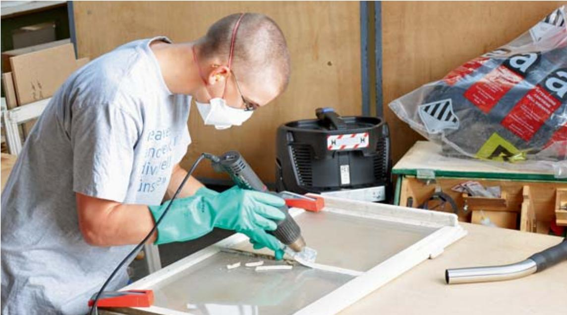
Entfernen von asbesthaltigem Fensterkitt mit Heissluftföhn.
