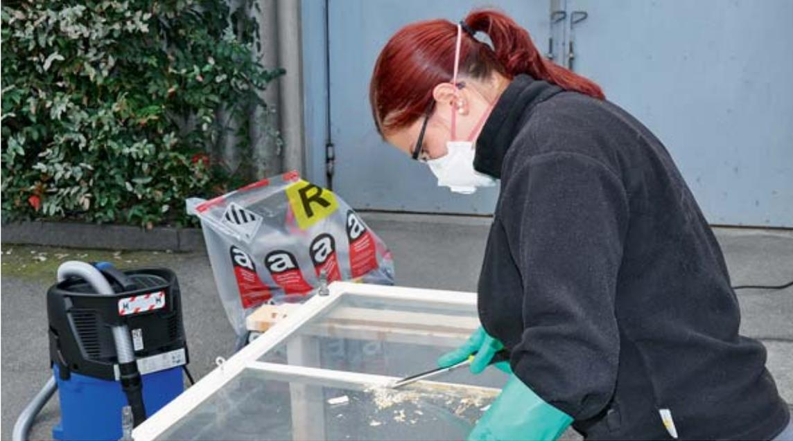
Entfernen von asbesthaltigem Fensterkitt mit Stechbeitel oder Spachtel.
