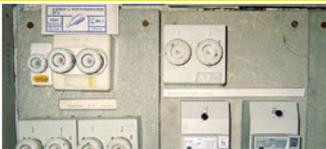
Asbestzementplatten hinter Elektrozählern und Sicherungskästen
