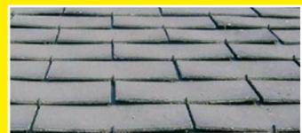
Asbestzement Dächer (Vorsicht beim Dachfenstereinbau)
