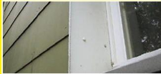
Asbestzement Fenster und Wandverkleidungen
