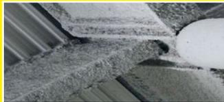
Spritzasbest an Metalltragkonstruktionen
