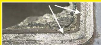
Isolamento termico contenente amianto per forni e piastre di cottura
