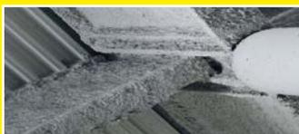
Amianto spruzzato in strutture portanti in metallo
