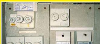
Lastre in cemento-amianto dietro a contatori elettrici e scatole dei fusibili
