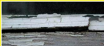
Mastice per finestre contenente amianto con colori resistenti alle intemperie
