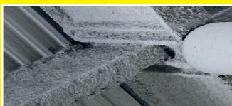
Amianto spruzzato in strutture portanti in metallo
