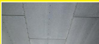
Rivestimenti di soffitti in cemento-amianto e rivestimenti di sottotetti
